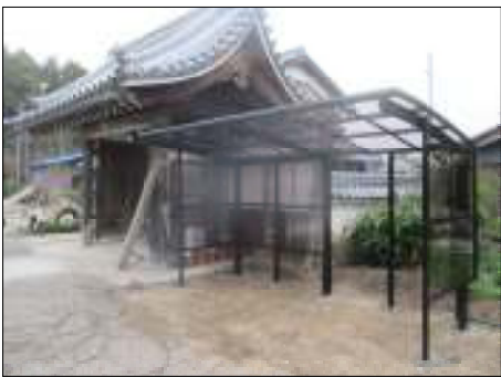
工事中の山門脇駐輪場の様子
