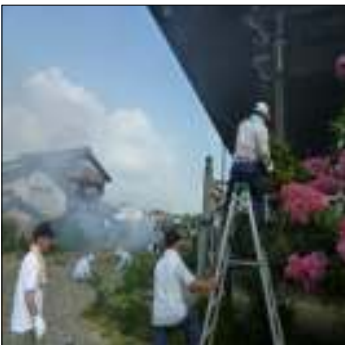
清掃作業の様子
